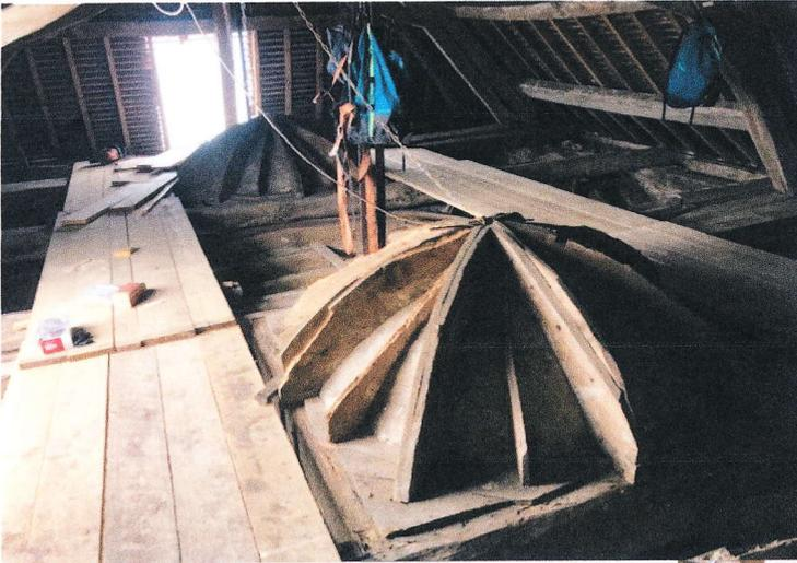
Les armatures de deux coupôles vers l'entrée en planches et plâtre .
