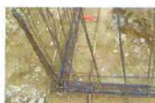
Nœud de chaînage : Continuité mécanique
